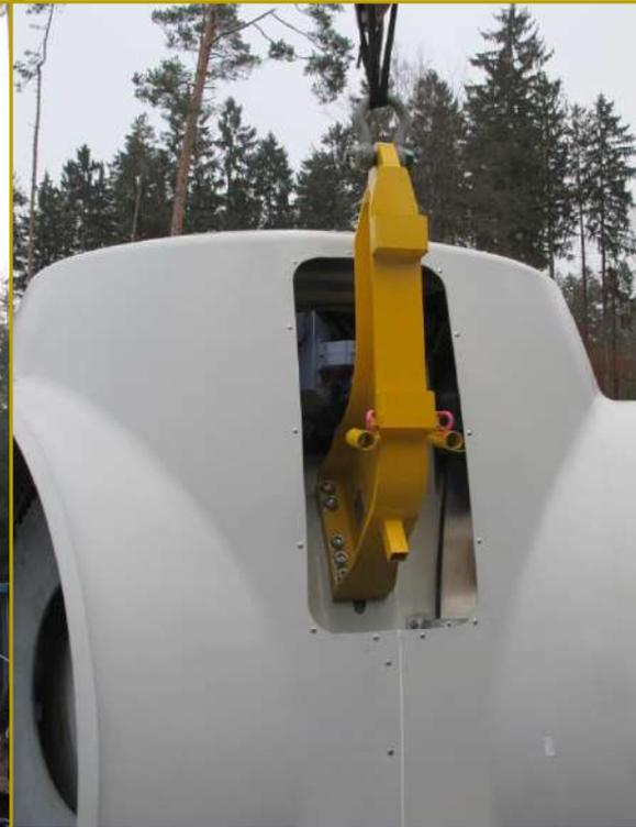
Traversensystem Heben und Drehen Nabe 3 MW
