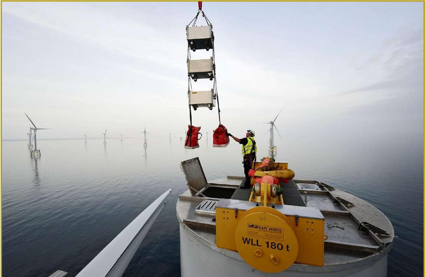
Lastaufnahmemittel Turm SWL 280 t mit Verschlussdeckel
