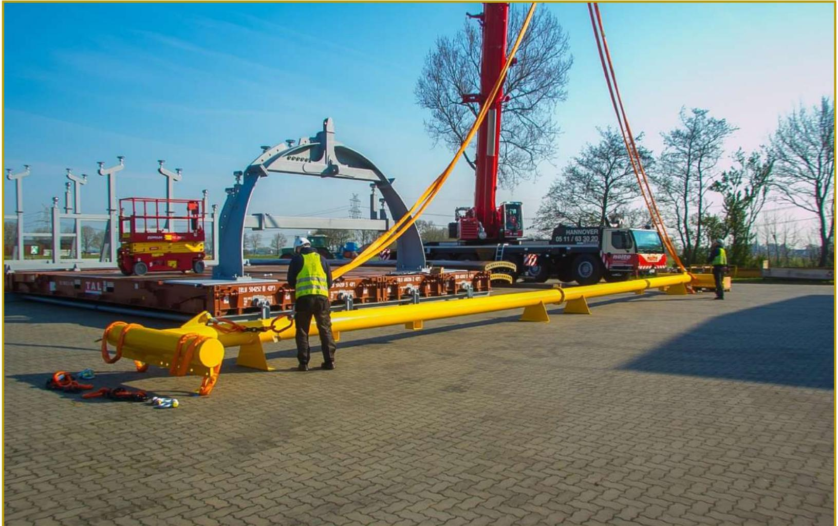
Spreize und Vormontageeinrichtung segmentierter Stahlrohrturm
