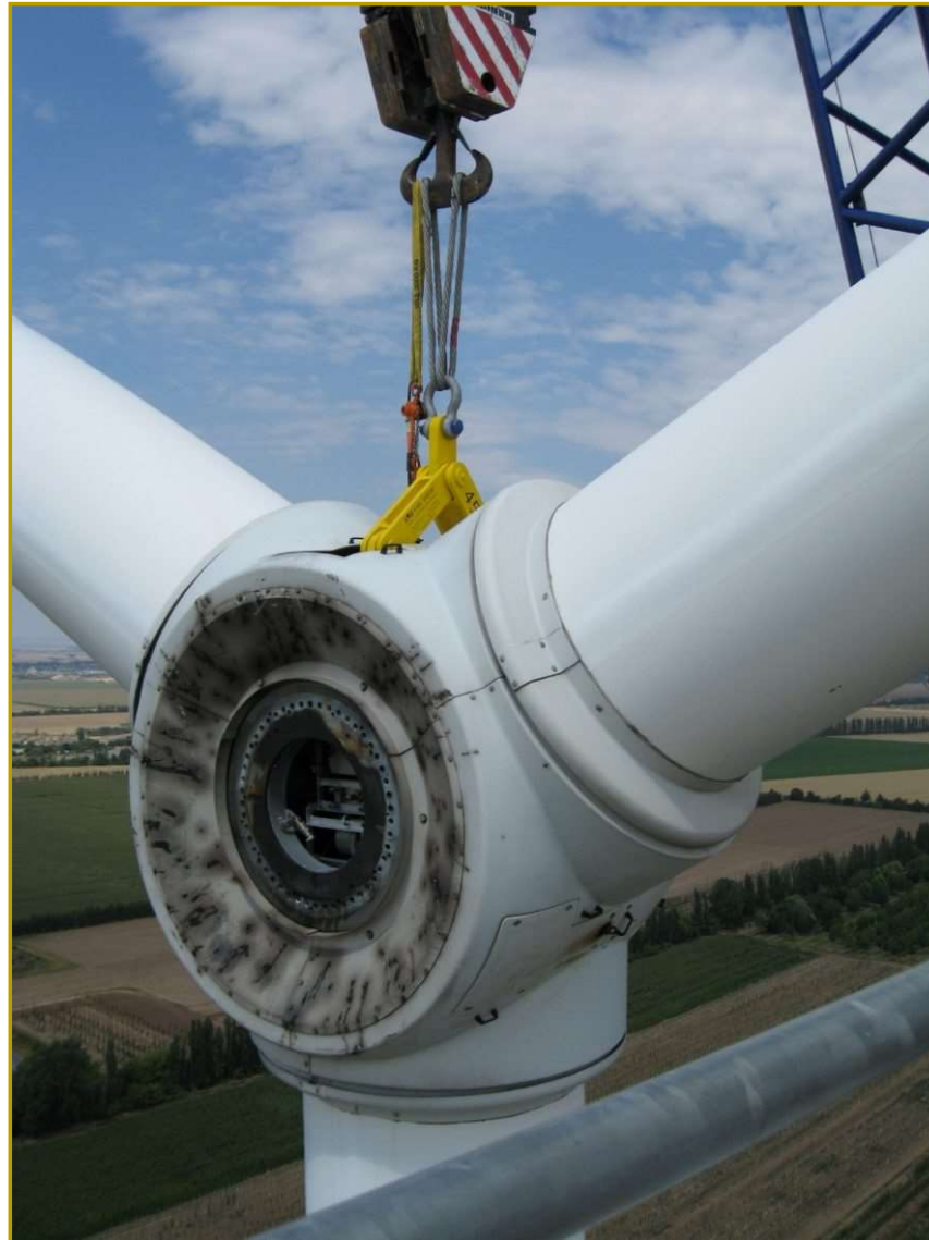
Rotorsterntaverse 2 MW
