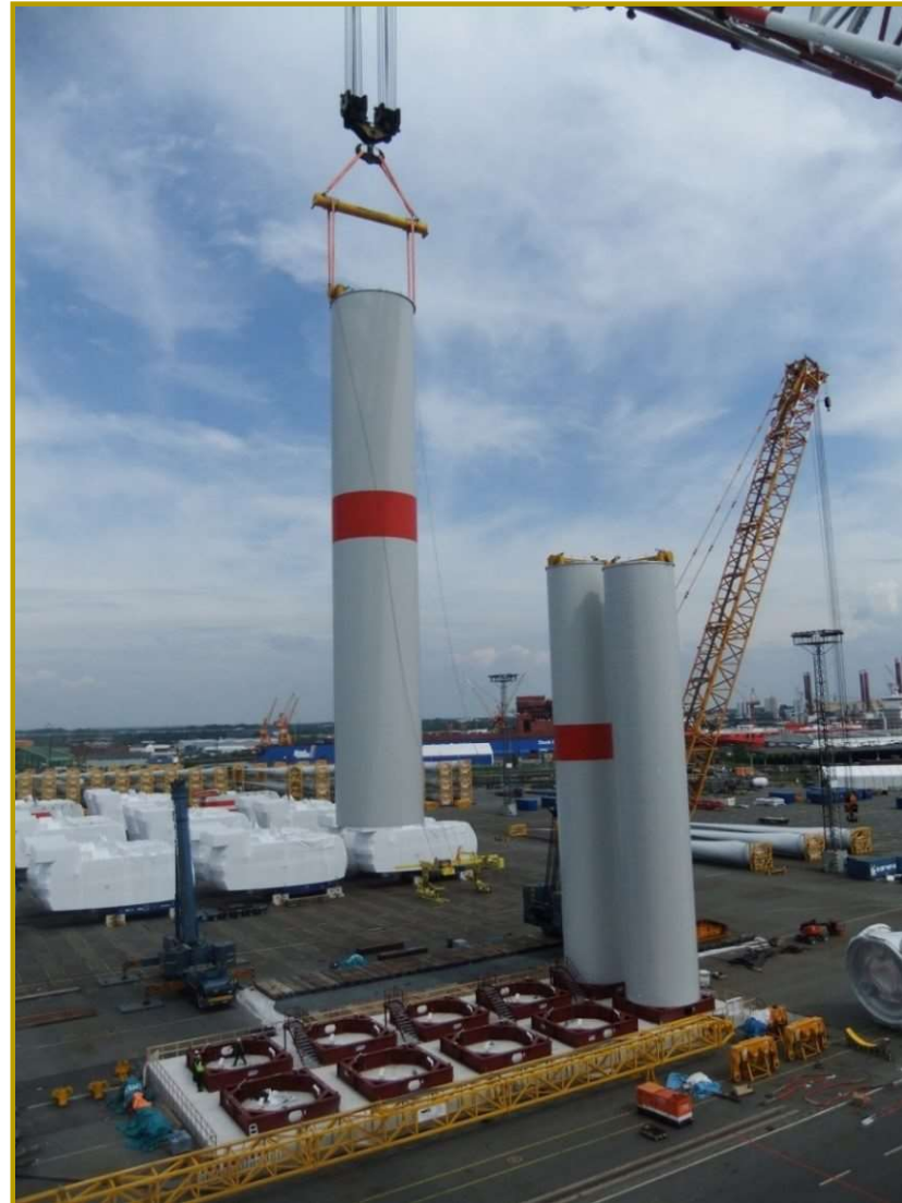
Lastaufnahmemittel Spreize und Turm SWL 280 t
