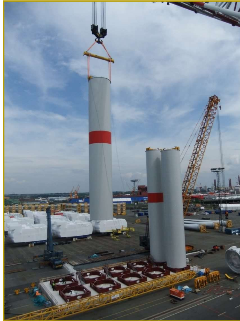
Spreize SWL 280 t und Turmhebemittel im Einsatz
