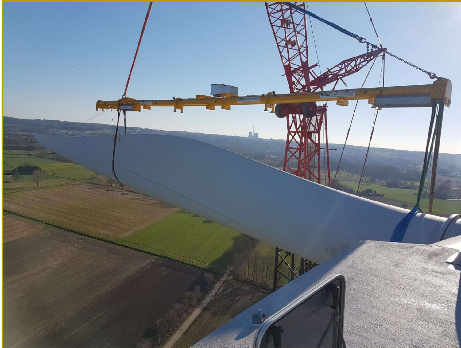
funkferngesteuerte Einzelblattmontagetraverse
