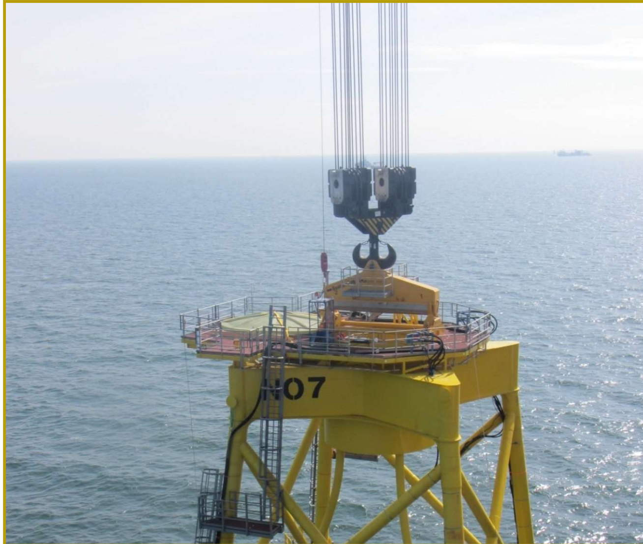
Installationstraverse SWL 650 t im Einsatz
