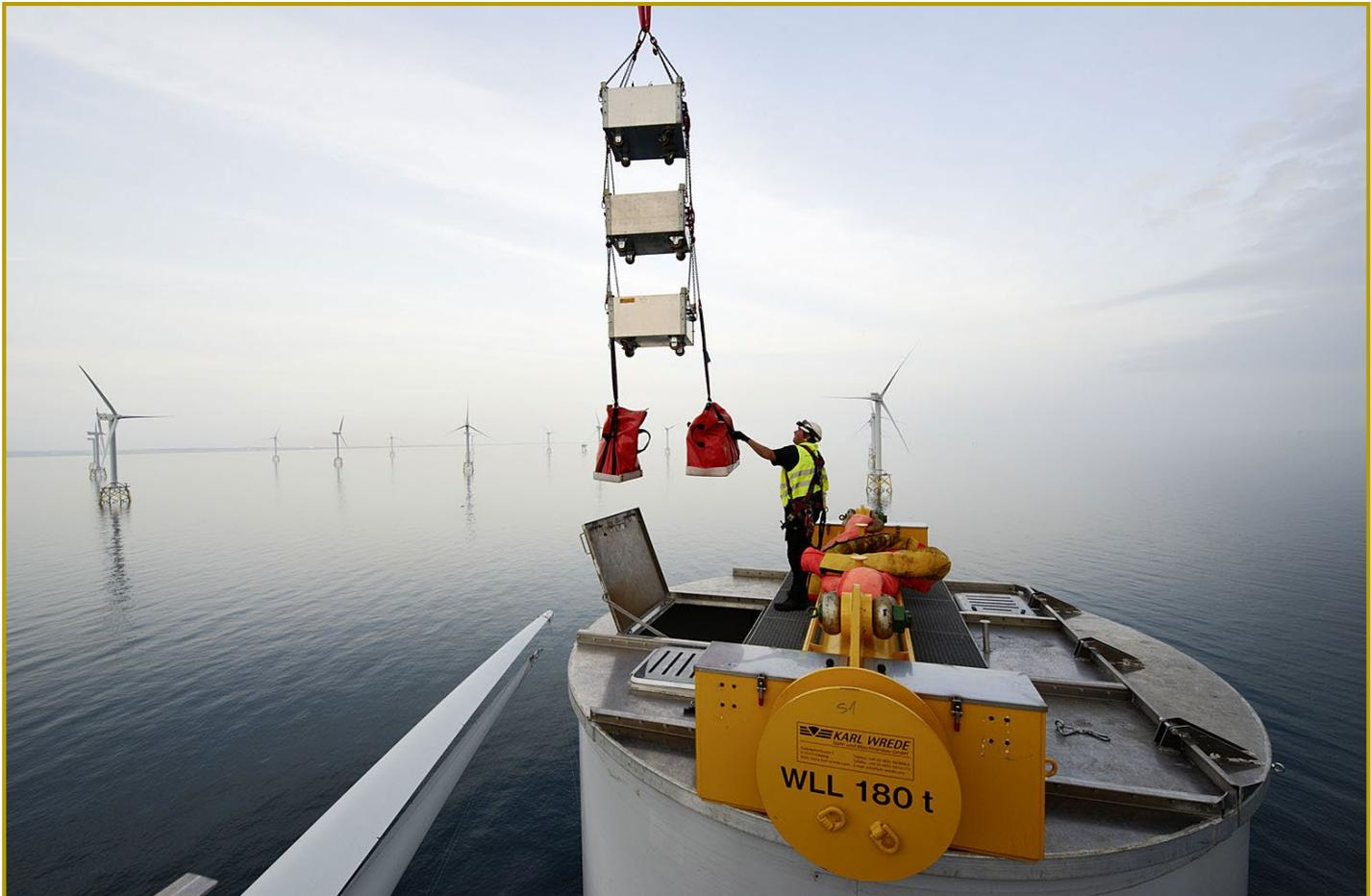
Lastaufnahmemittel Turm SWL 280 t mit Verschlussdeckel
