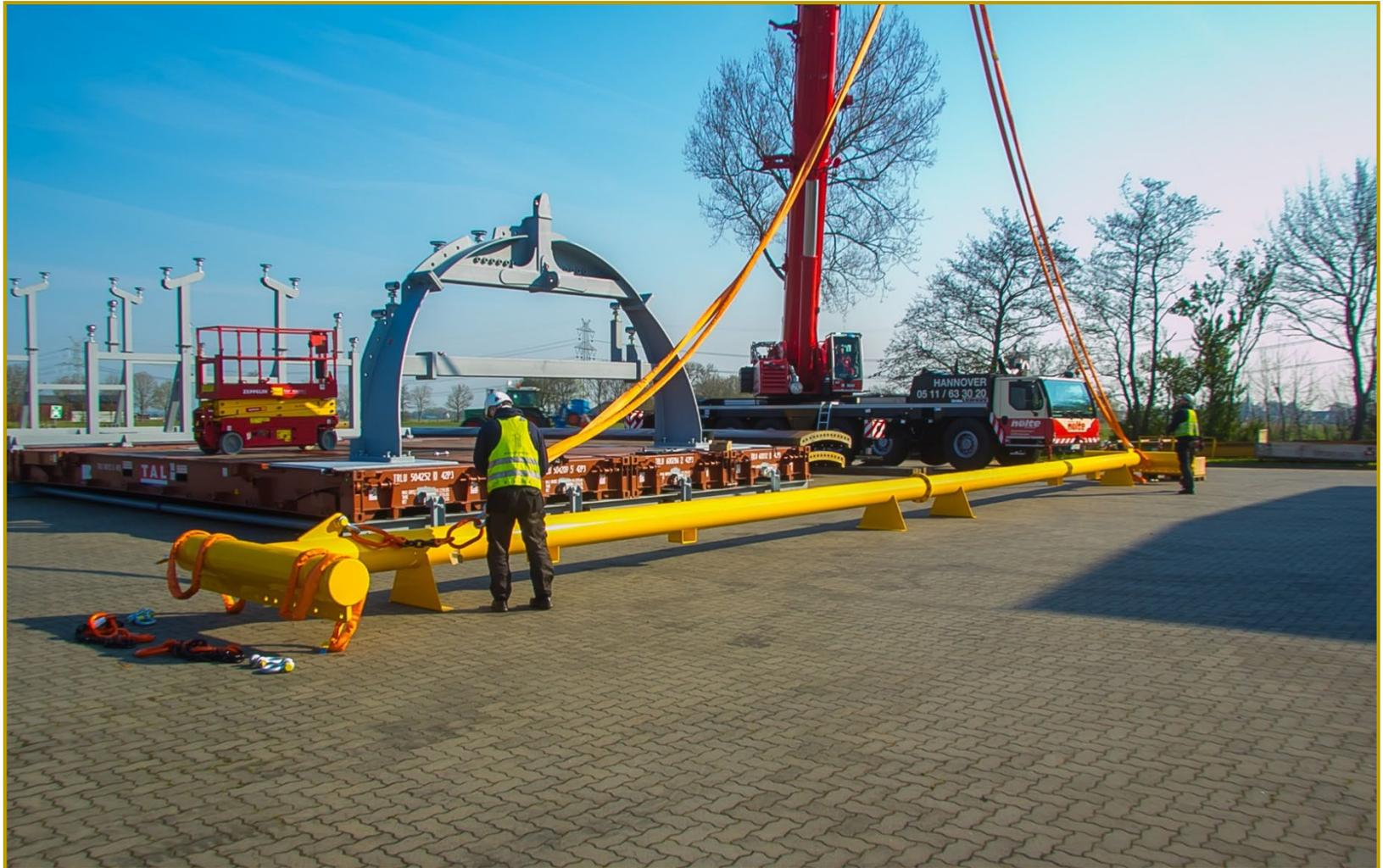
Spreize und Vormontageeinrichtung segmentierter Stahlrohrturm
