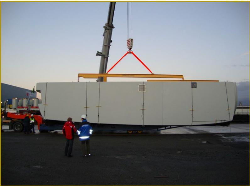
Traversensystem Gondelverkleidung 6 MW
