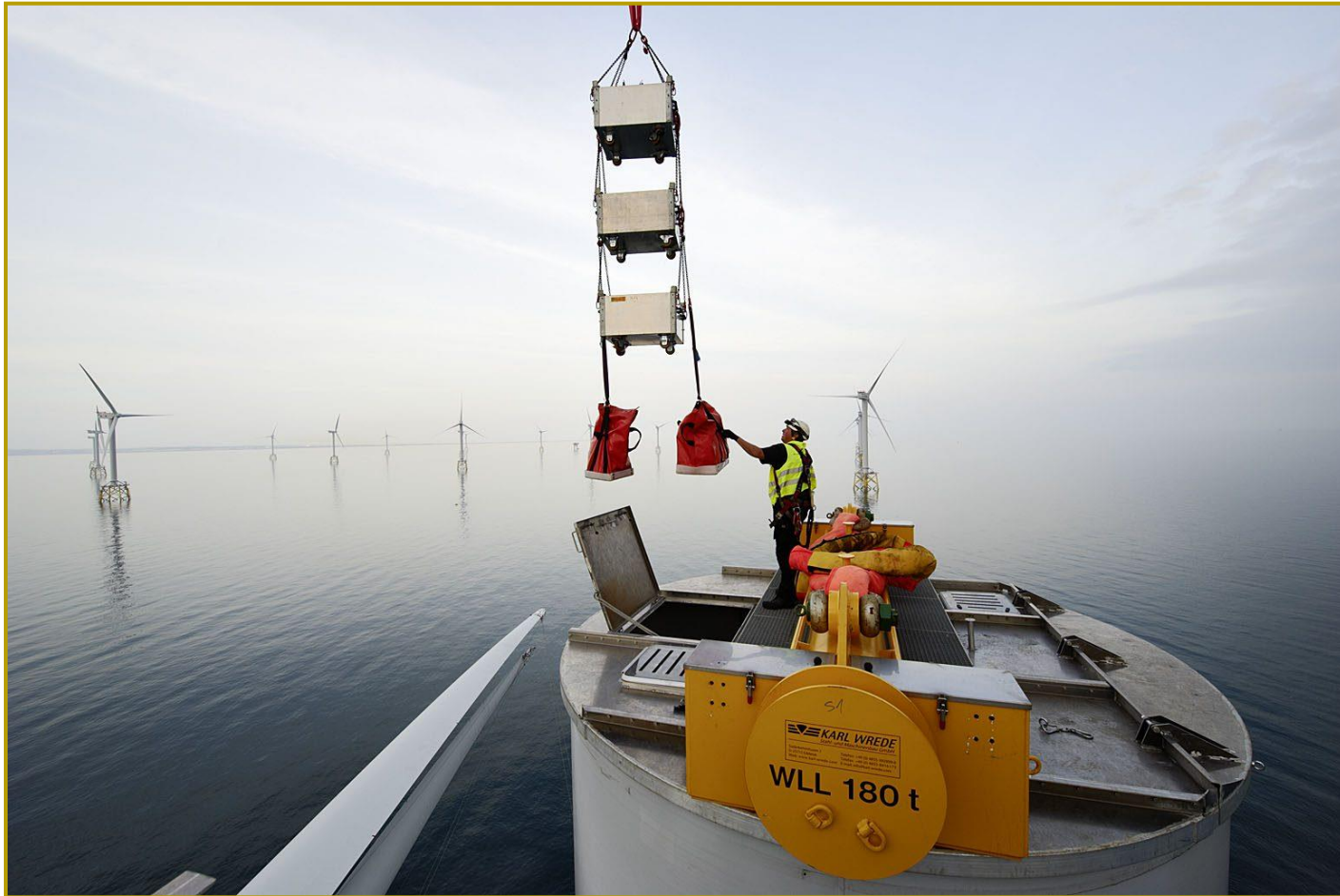
Lastaufnahmemittel Turm SWL 280 t mit Verschlussdeckel
