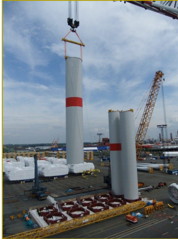
Lastaufnahmemittel Spreize und Turm SWL 280 t
