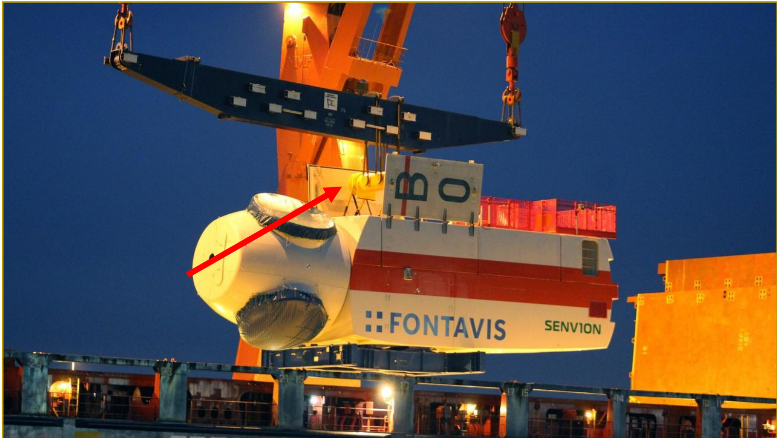
Gondeltraverse SWL 480 t – manuelle Schwerpunktverstellung
