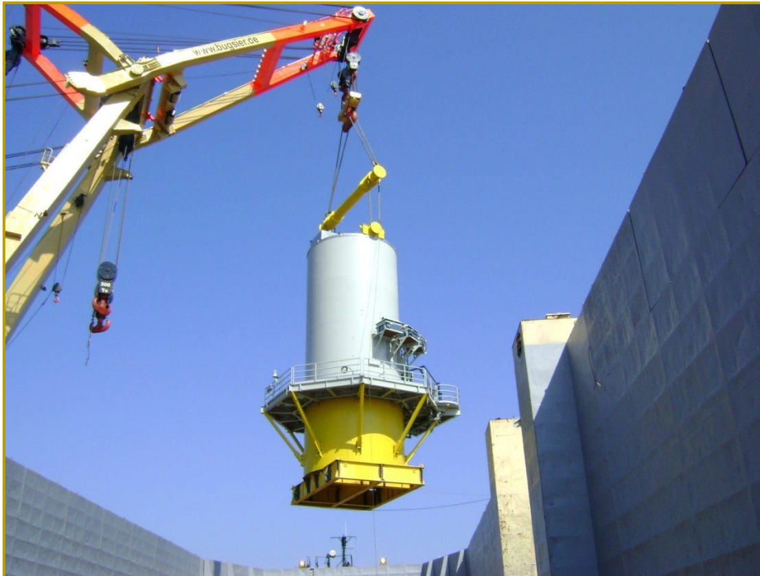
Spreize, Hebetraverse und Transportrahmen Turmsection 5 MW
