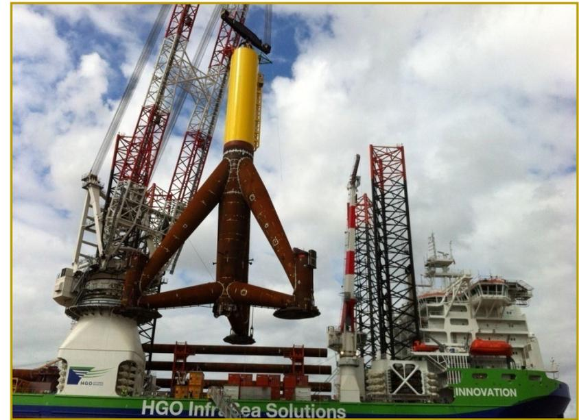
**funkferngesteuerte und vollautomatische Installationstraverse SWL 950 t im Einsatz**
