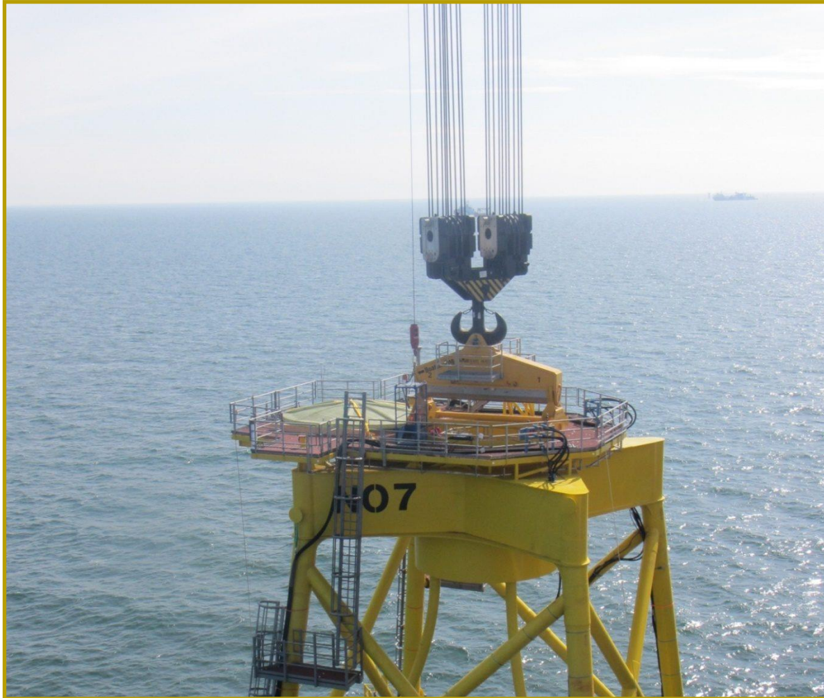
Installationstraverse SWL 650 t im Einsatz
