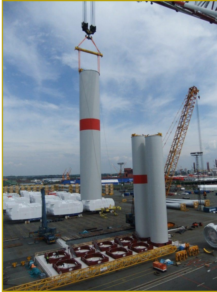
Spreize SWL 280 t und Turmhebemittel im Einsatz
